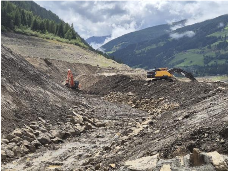
Kanal, der gebaut wurde, um das Wasser der Falschauer zum Einlaufbauwerk zu bringen.
