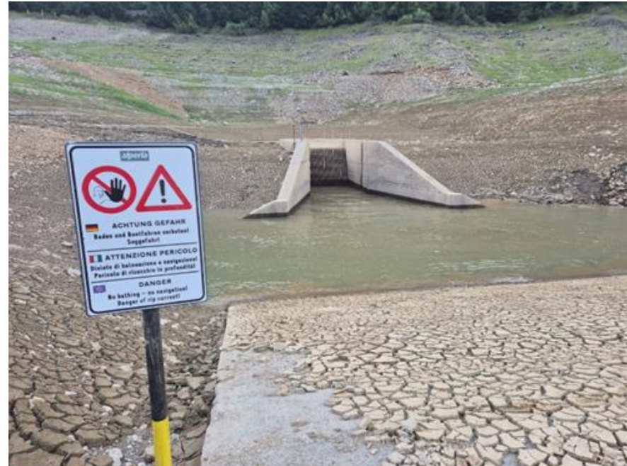
Einlaufbauwerk zum Triebwasserstollen, der das Wasser nach Sankt Pankraz leitet.
